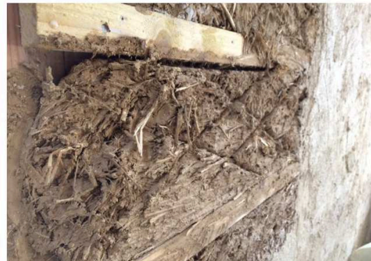
Les murs intérieurs sont constitués de torkhis, mélange de paille et de l'argile qui est trouvée sur place.
