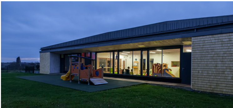
Crèche en paille dans le Loir et Cher. Elle a obtenu la « certification Passivhaus » ou maison passive. Les appareils de chauffage n'y sont pas nécessaires. ©Corentin Desmichelle.
