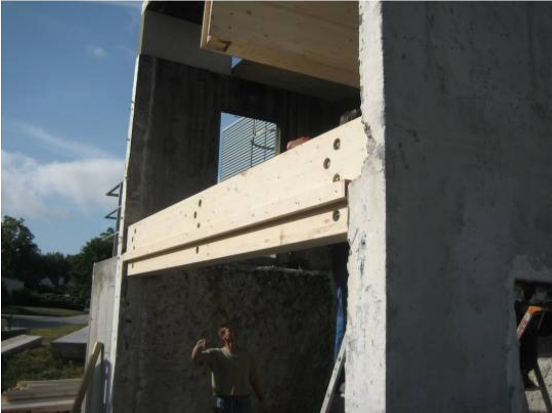
Mise en œuvre de la poutre transversale
