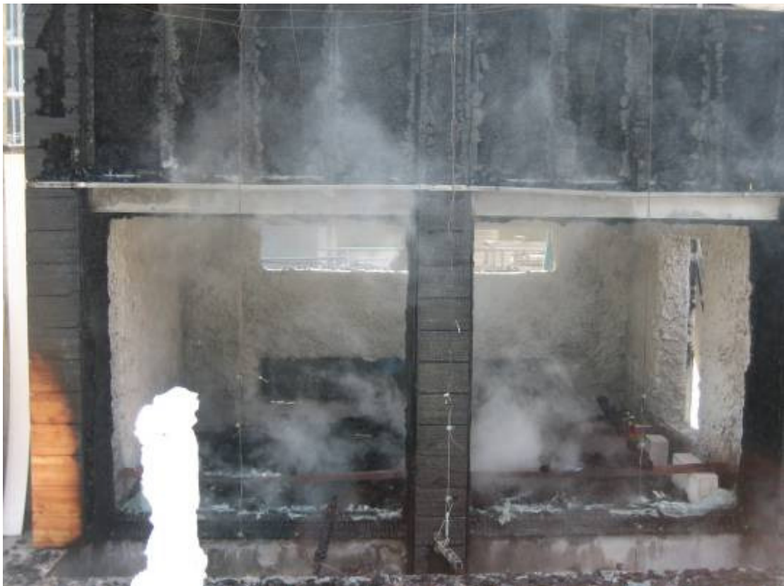
Détail des allèges et trumeau central niveau N
