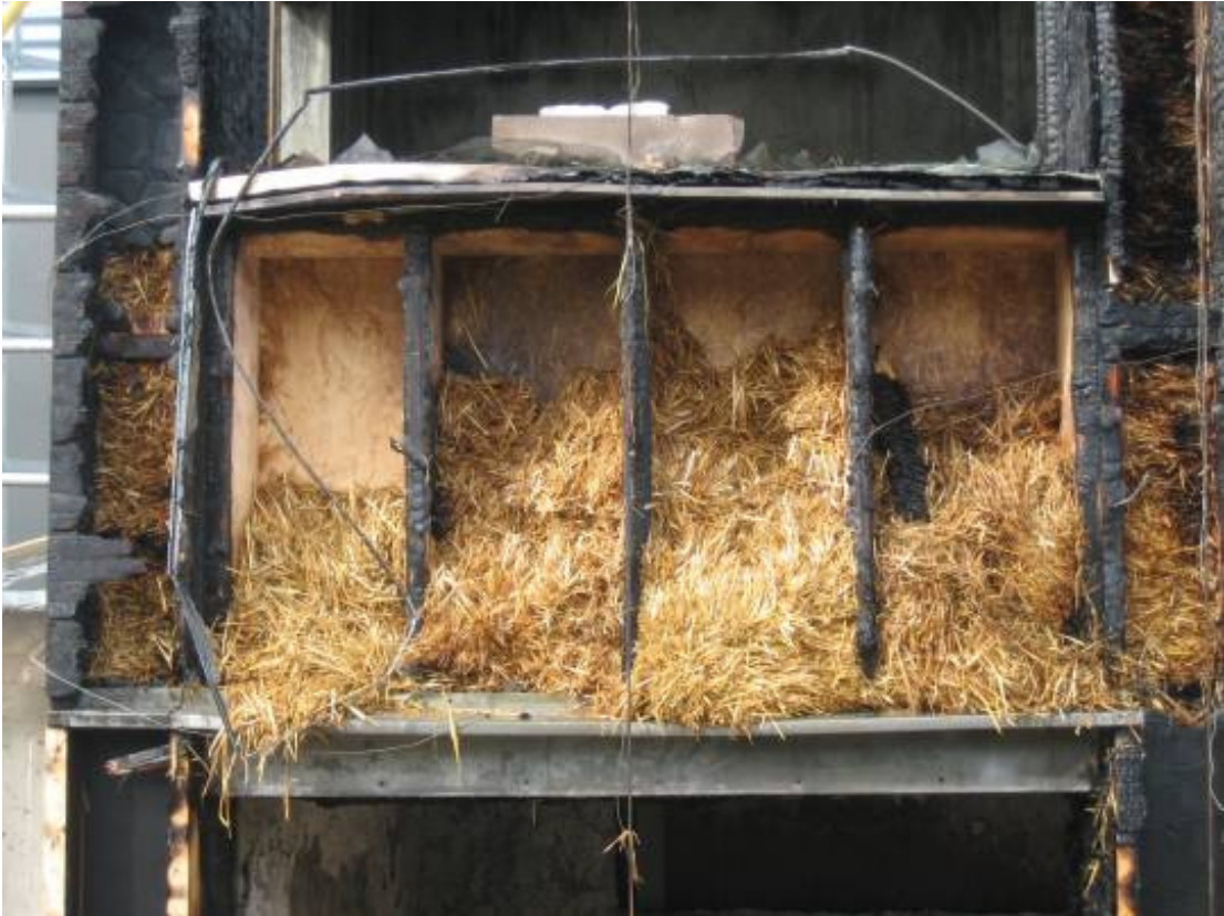
Allège N+1 SUD après dépose de la paille
