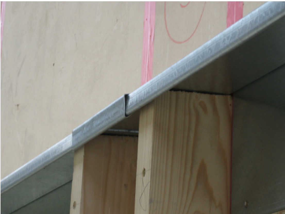
Détail du recouvrement des tôles de recouvrement au trumeau central
