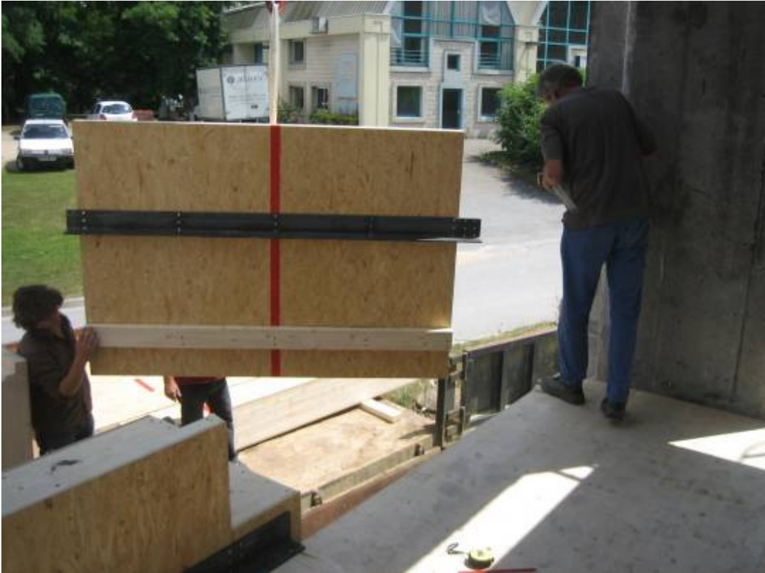
Mise en œuvre des allèges
