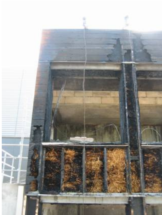
Vue des niveaux N+1 et N+2 (SUD)
