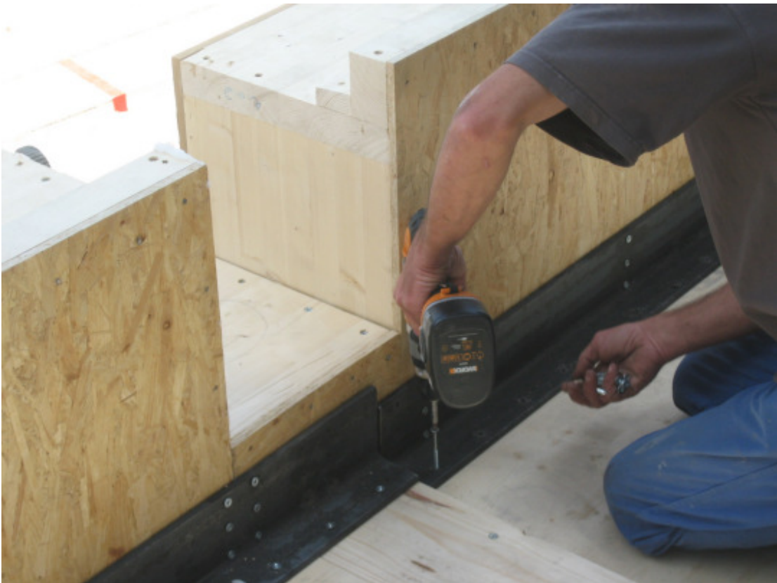
Mise en œuvre du trumeau central
