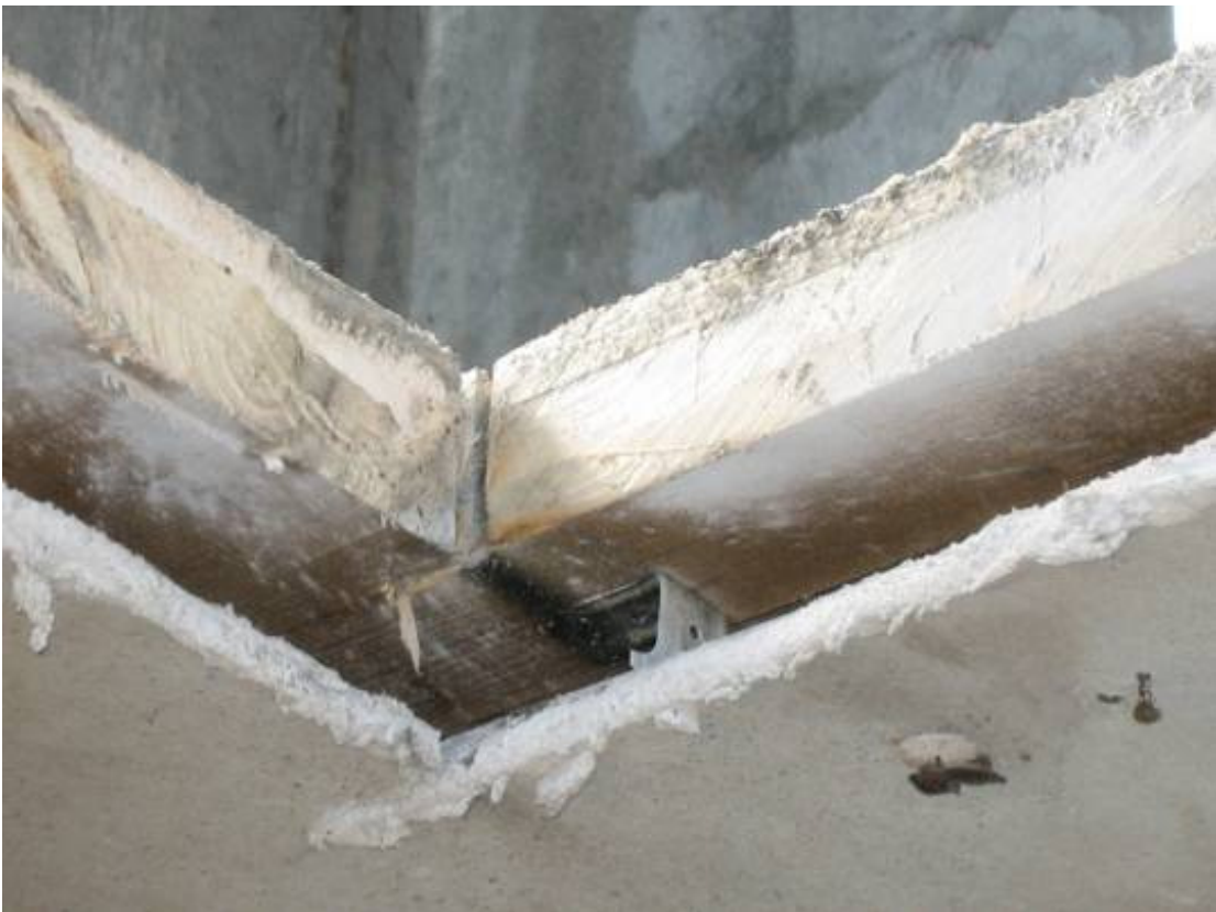
Coupe du plancher SUD en partie courante
