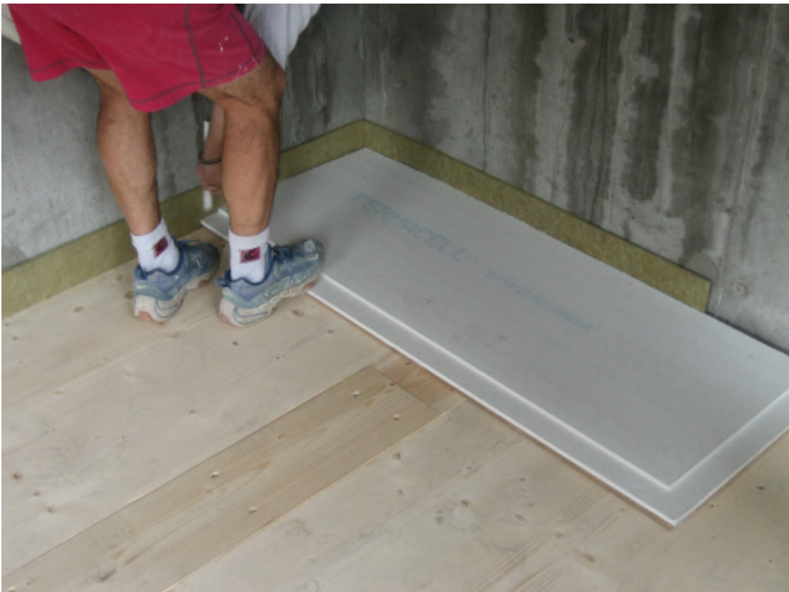
Mise en œuvre de la chape sèche
