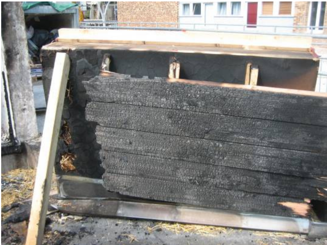
Vue de l'allège NORD niveau N+1
