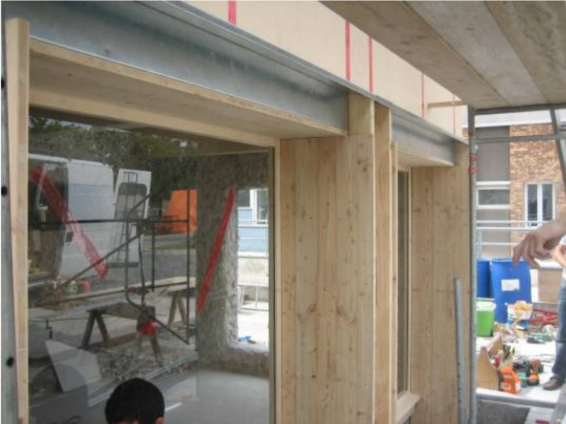
Mise en œuvre des tôles de recouvrement des vides de bardage
