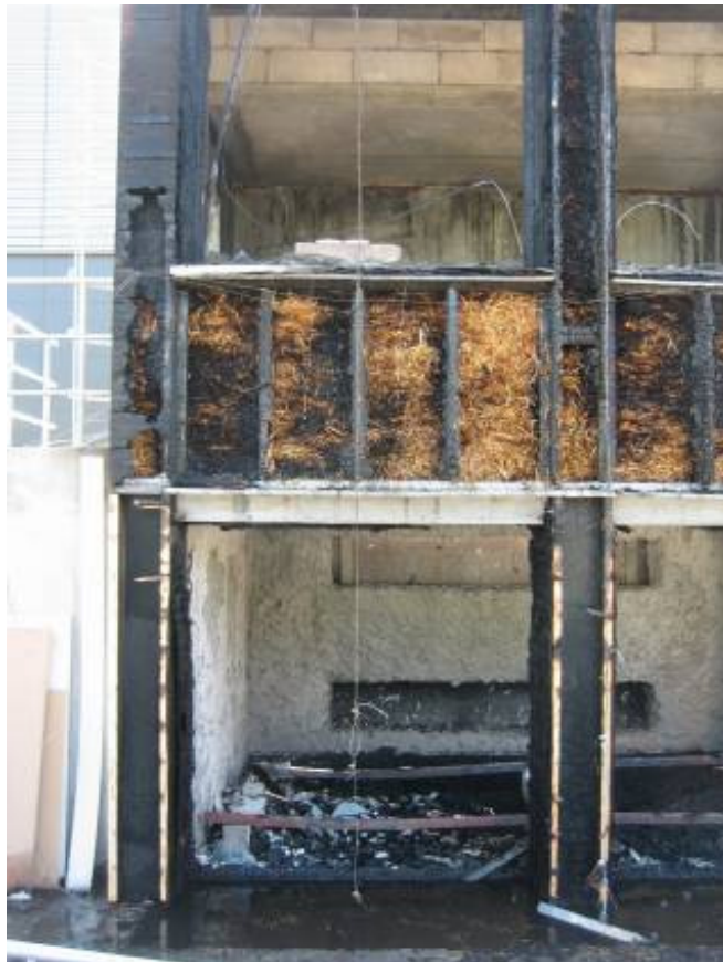
Vue de l'allège SUD après refroidissement
