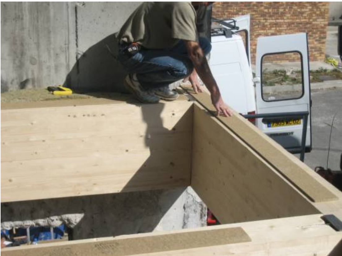
Mise en œuvre des bandes résilientes
