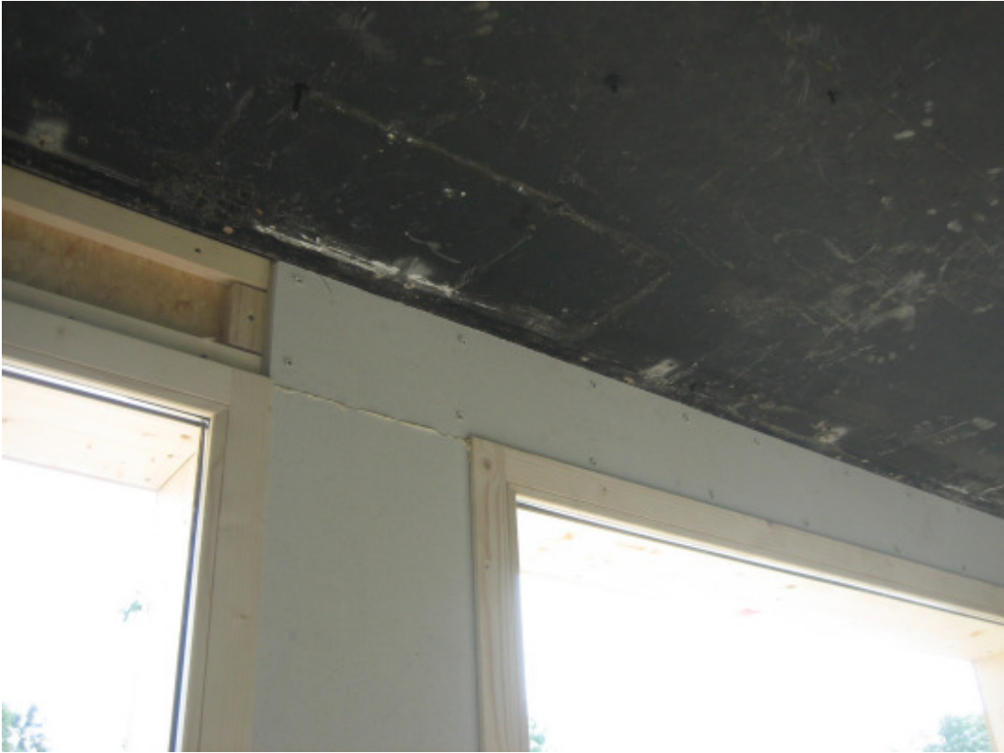
Mise en œuvre des habillages intérieurs
