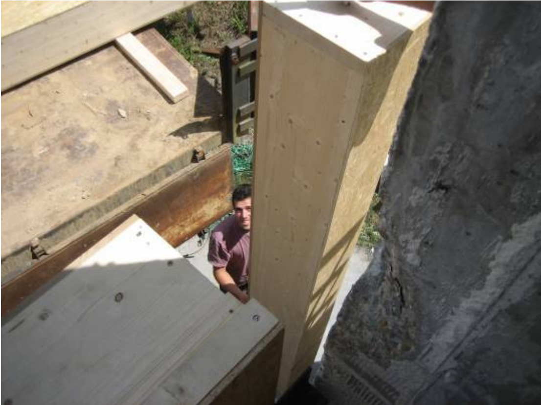
Mise en œuvre du trumeau latéral
