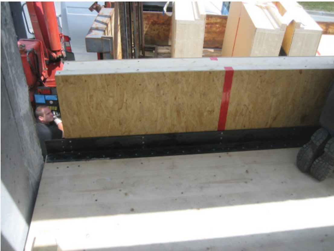
Mise en œuvre des allèges
