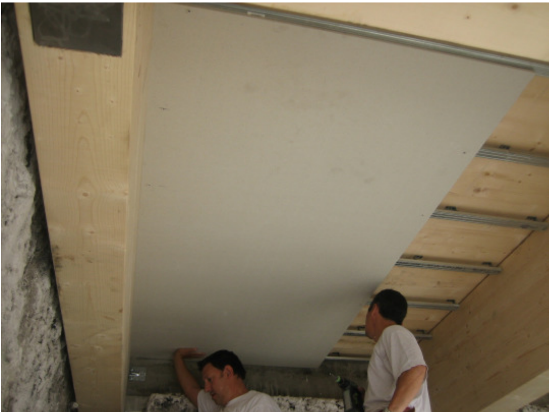
Plancher SUD, parement de faux plafond
