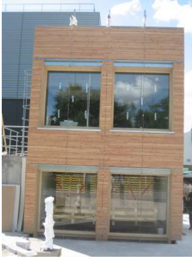
Vue de la façade à t = 0
