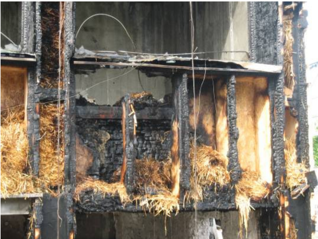
Allège N+1 NORD après dépose de la paille
