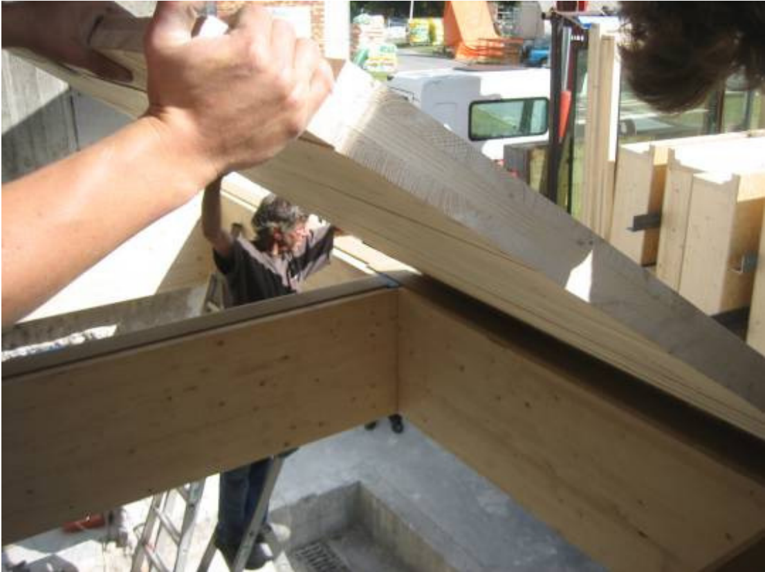
Mise en œuvre des planchers
