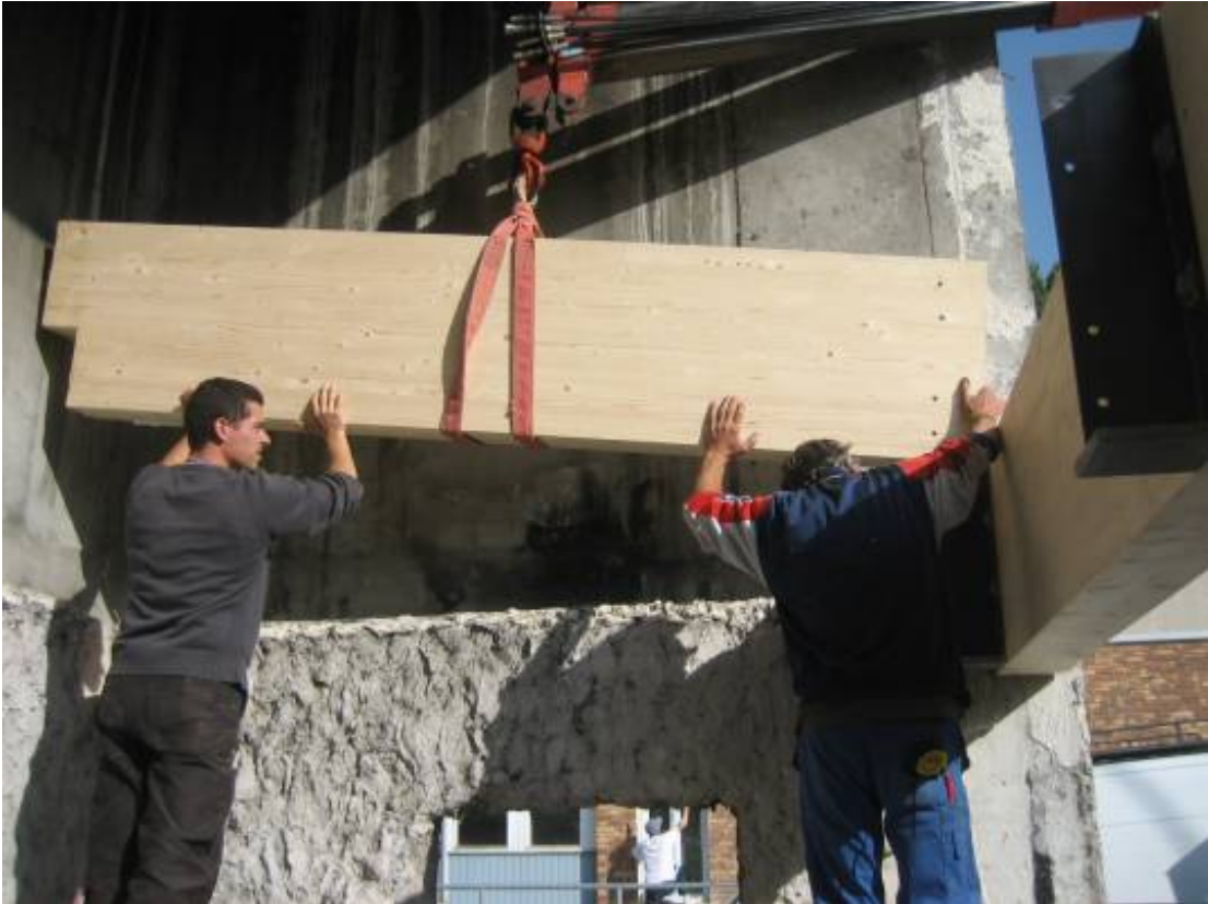
Mise en œuvre des poutres longitudinales
