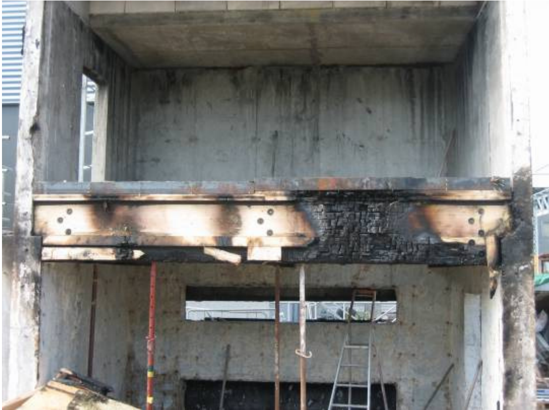
Vue de la poutre transversale après dépose des allèges
