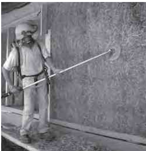
Figure 9 : Dressage des parois en paille
