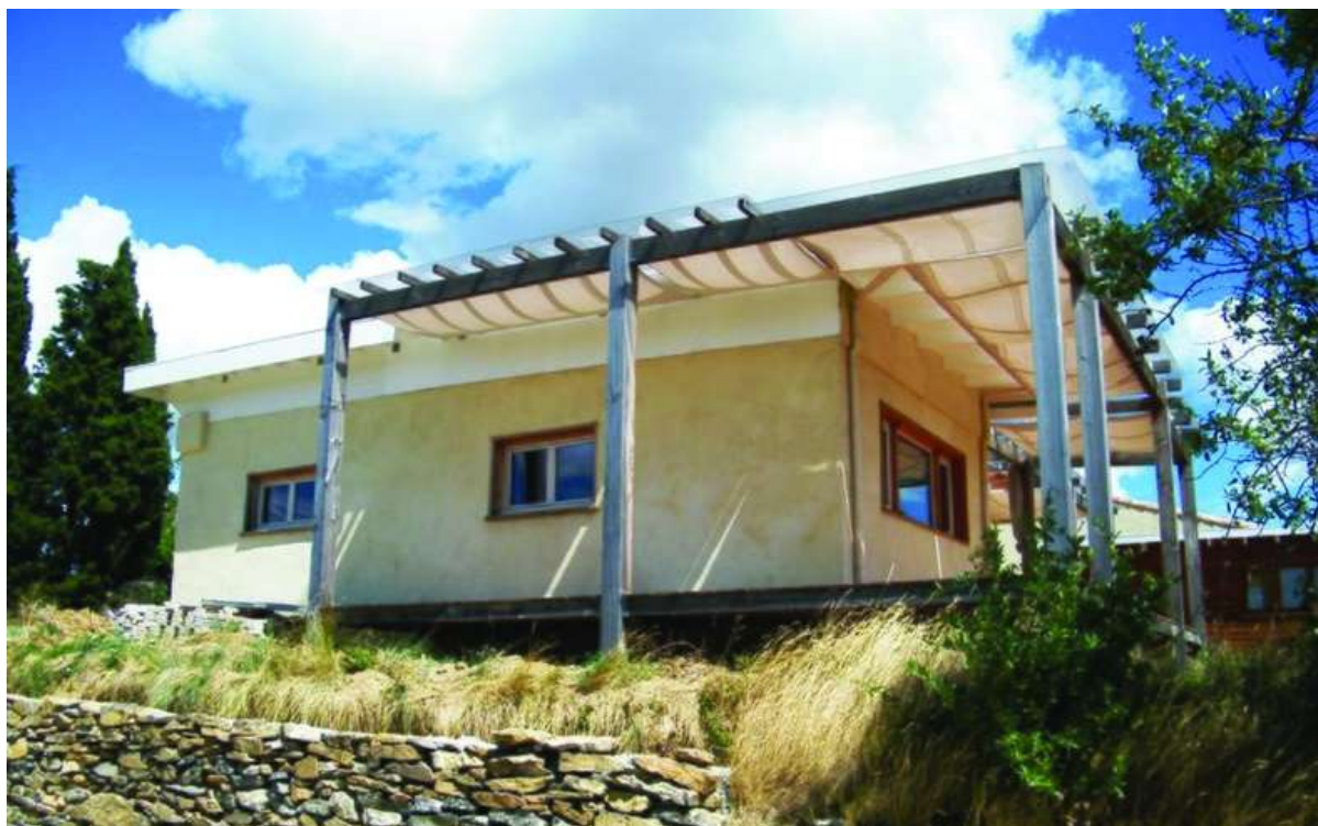
Maison paille-porteuse en botte de paille de riz (Aude), crédit Coralie Garcia
