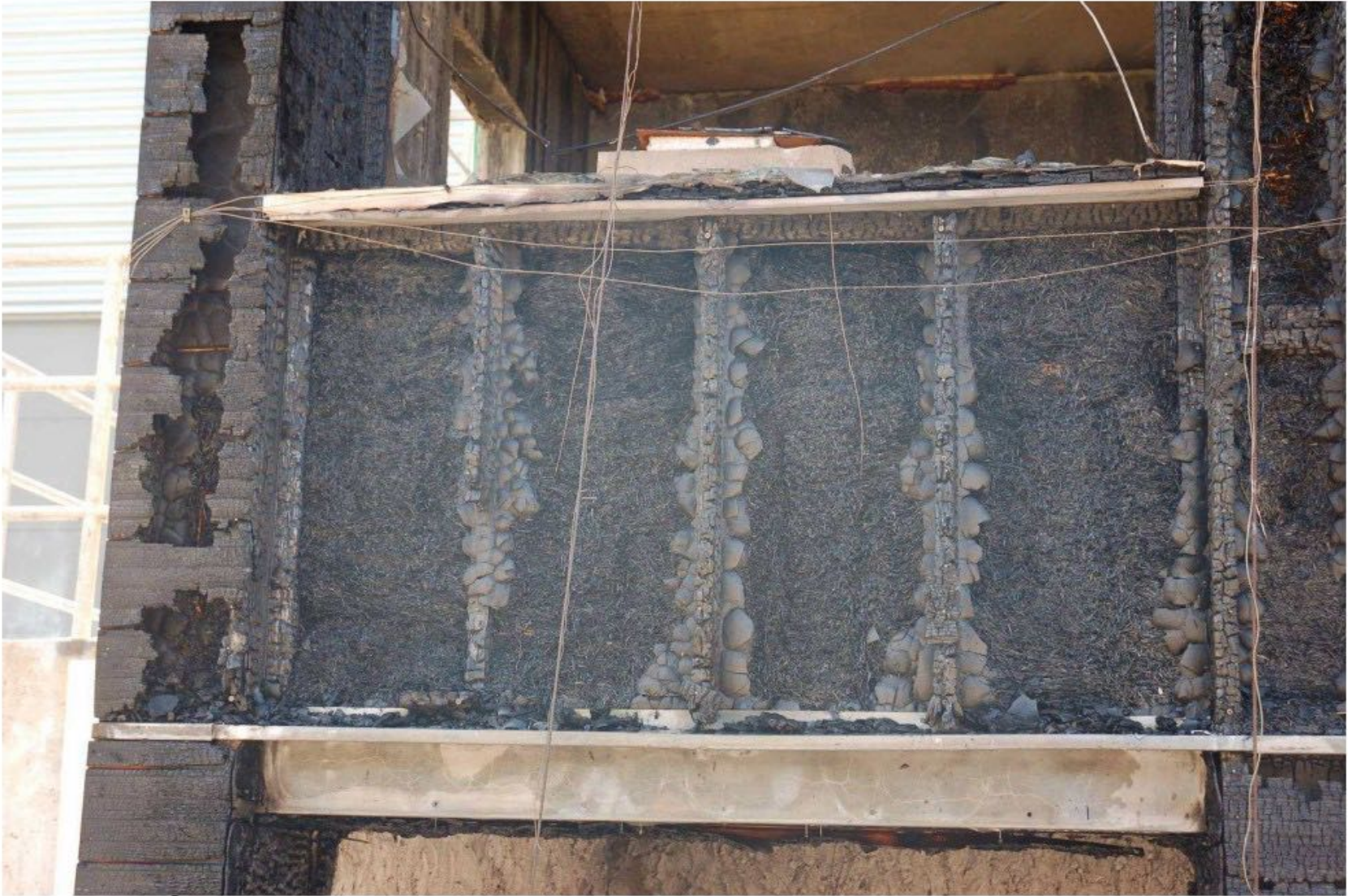
FIRE TEST LEPIR II - 2009
