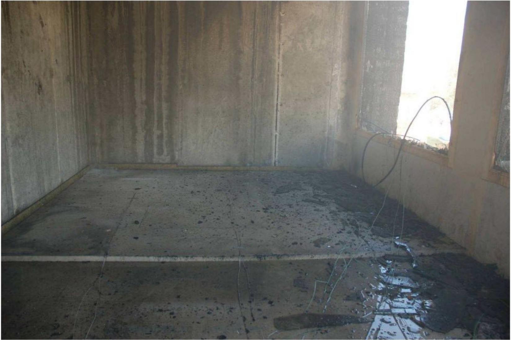
FIRE TEST LEPIR II - 2009
