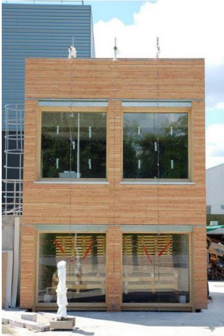
FIRE TEST LEPIR II - 2009
