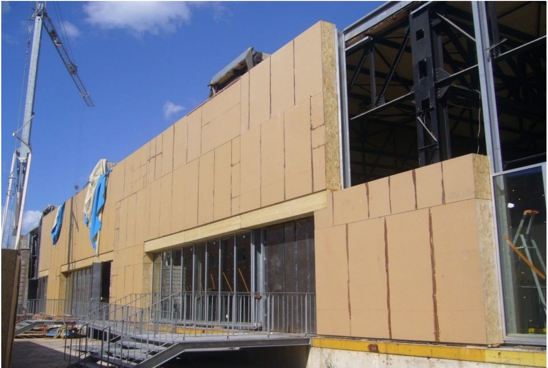
Cartonnerie de la friche de la belle de mai. External insulation of a theater - 2010
