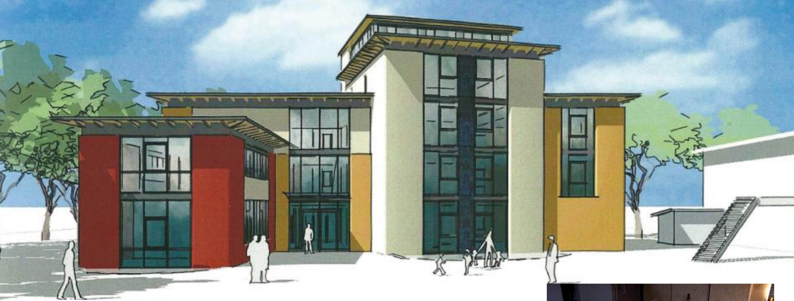
NZNB – Norddeutsches Zentrum für Nachhaltiges Bauen 5 Story Straw Bale Building in Verden Germany from 2012-2015
